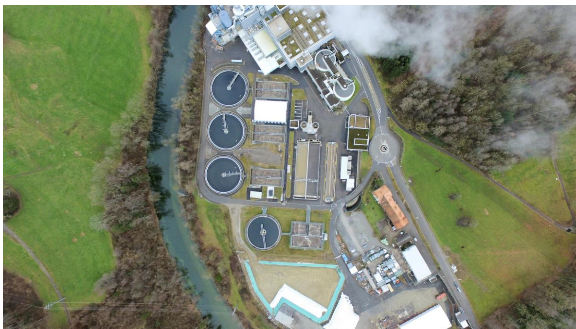
ARA St.Gallen-Au [Entsorgung St.Gallen].
