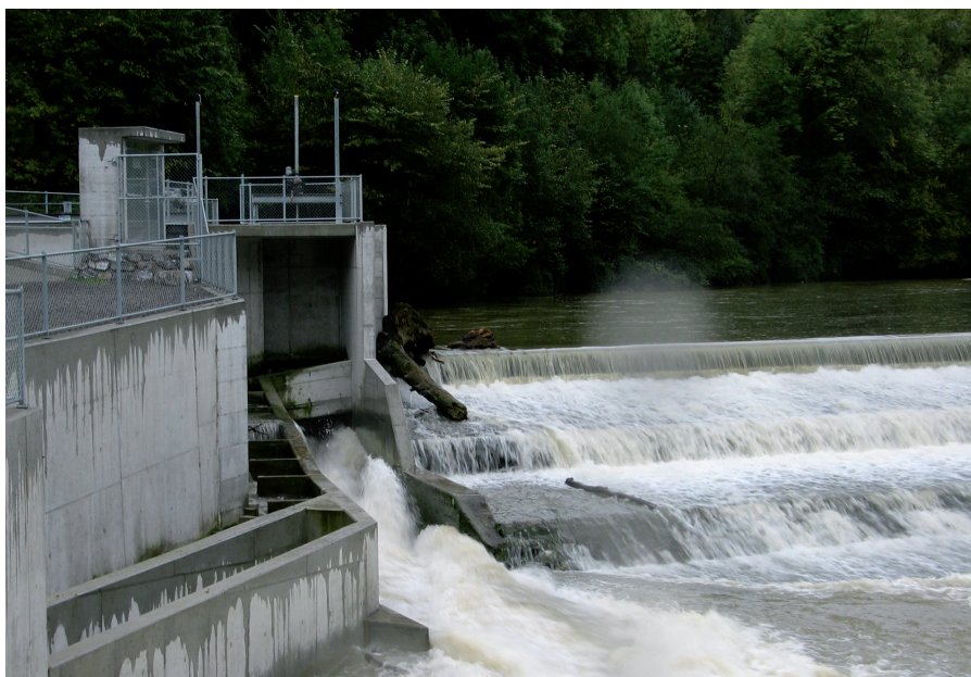
Das Kraftwerk Sittertal mit der Fischtreppe.
