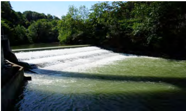
Abbildung 86: Wehr des KW Sitterthal vom Unterwasser aus betrachtet. Links im Bild der Eingang zum Fischpass.
