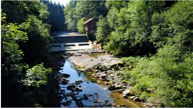
Abbildung 90: Das Stauwehr List vom Unterwasser aus gesehen.
