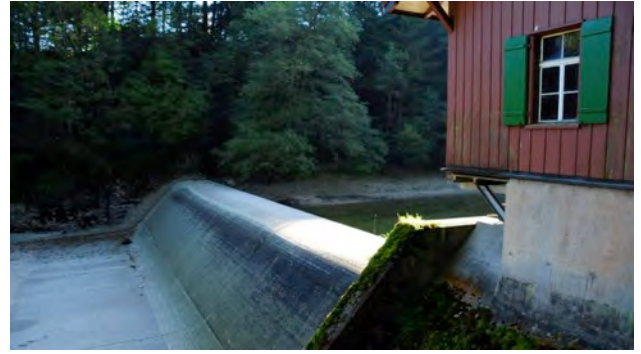
Abbildung 91: Dem Wehr List fehlt eine Fischeufstiegsanlage. Es ist für Fische in Richtung stromaufwärts nicht passierbar.
