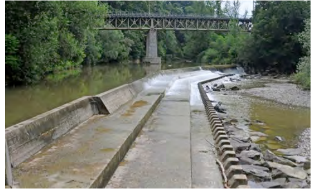
Abbildung 85: Wehr Sitterdorf bei leichter Überströmung.
