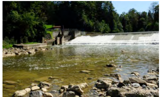
Abbildung 89: Das Wehr des KW Erlenholz bei Schwall.
