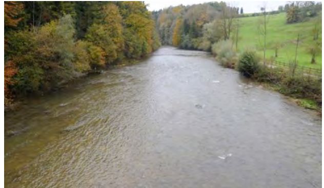
Abbildung 42: Untersuchungsabschnitt S-7: Bereich Wittenbach-Wannenbrugg; Blick bachabwärts; Sunk.
